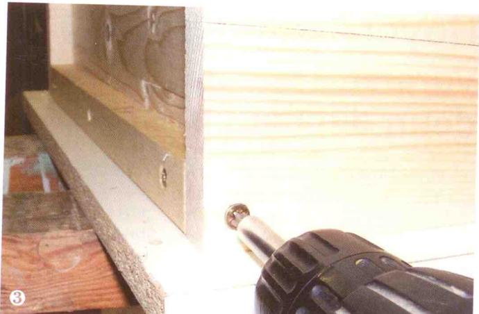
3 Nun in den vier unteren Ecken der Seitenteile Löcher vorbohren und jeweils eine Holzschraube (50 mm lang) in das Stirnholz der Setzleiste drehen.
